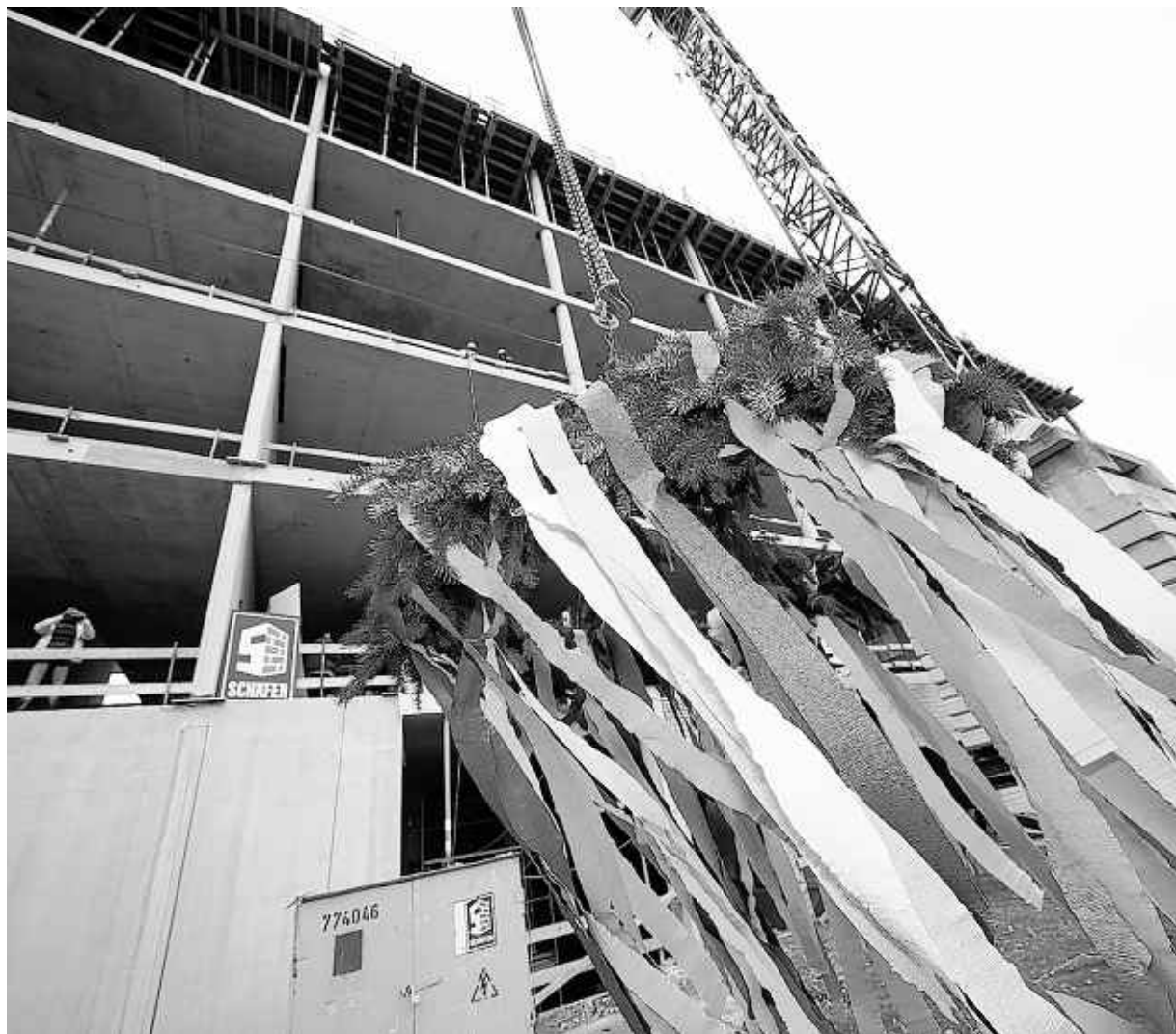
Feierstunde auf dem Campus Melaten: Auf dem Rohbau des RWTH-Verfügungszentrums wurde gestern der Richtkranz gesetzt. Für 32 Millionen Euro entstehen dort neue Räume für die Biologen. Foto: Andreas Steindl
