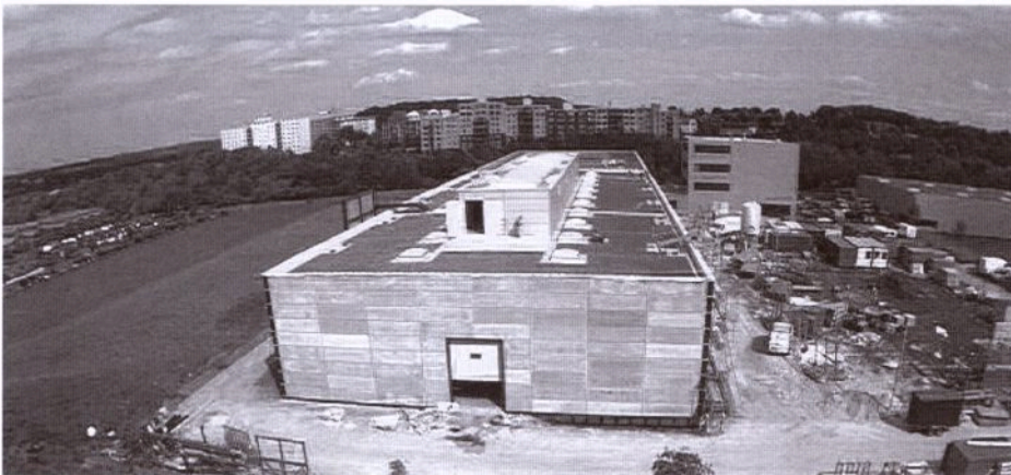
Ansicht Westfassade mit Textilbetonelementen INNOTEX 2.BA
